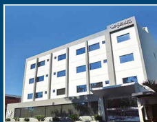
Edificio Corporativo Asismed
