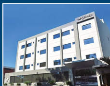
Edificio Corporativo Asismed
