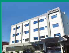
Edificio Corporativo Asismed
