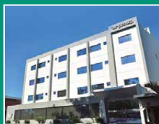
Edificio Corporativo Asismed
