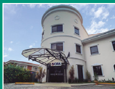
Centro Integral de Rehabilitación Asunción (CIRA)
