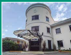
Centro Integral de Rehabilitación Asunción (CIRA)
