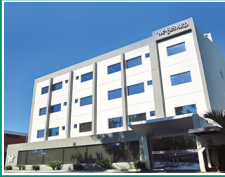
Edificio Corporativo Asimed
