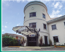
Centro Integral de Rehabilitación Asunción (CIRA)
